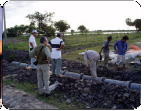
排水溝建設作業中
