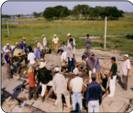
給水塔建設作業中
