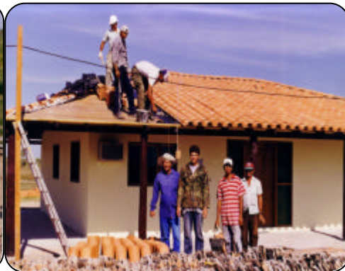
宿舍建設作業中
