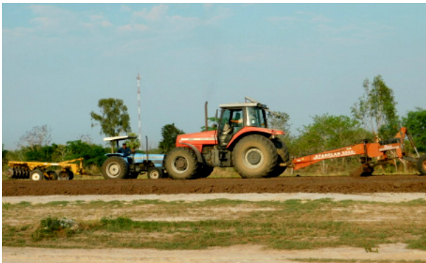
滑走路に土を盛り、均して固める工事の適期です。
