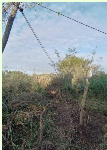
多種多様な植物が生い茂る自然環境。上にポンプ小屋への電気配線。
