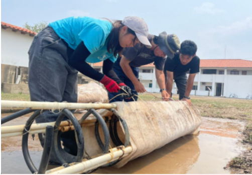
浄水場のろ過装置の掃除。10月26日
