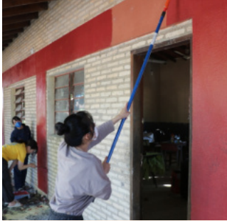
村の小学校の壁を塗装。
