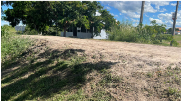
上の写真の崩落個所をしっかりと修復しました。
