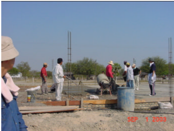
ディアナ村小学校の校舎建設 (土台造り)
